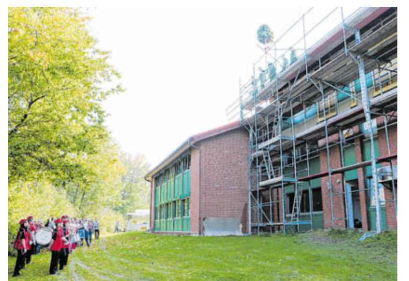
Der Spielmannszug Haffkrug sorgte für die Musik beim Richtfest von Timbertec. Ende Oktober soll der Anbau bezugsfertig sein.
